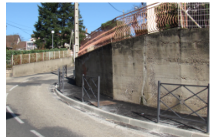
sécurisation des trottoirs - rue Bruget
