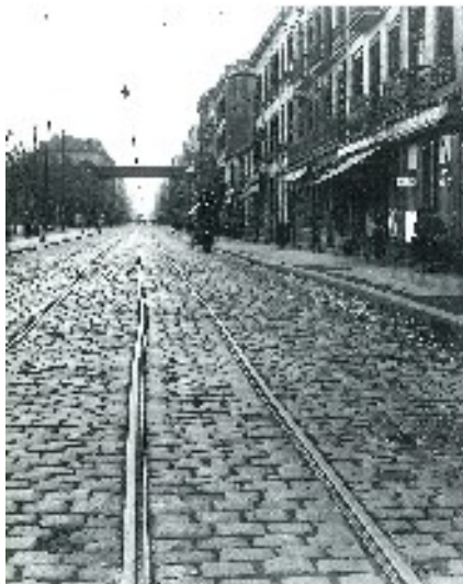
Illustration 35: Rails suivant les mouvements du sol – Photographie provenant du contentieux CFVE/Houillères
