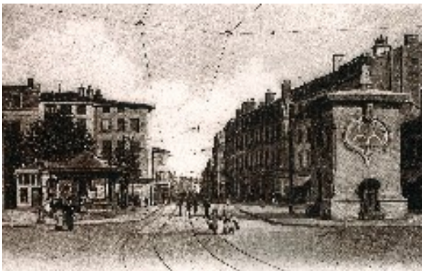
Illustration 28: Sous station électrique - Collection Jean-Paul Rahon
