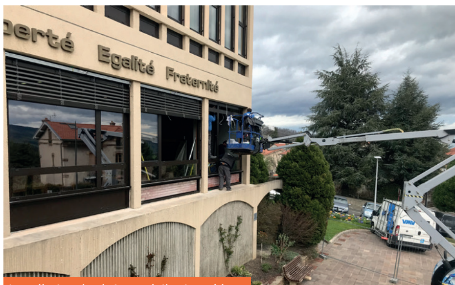
Installation des brise-soleil orientables
